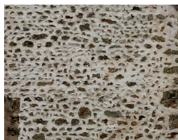
Enduit en pierre meulière
